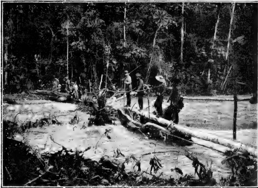
Fig. 41. Übergang über den Ingsiim.
